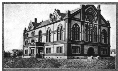
图2 柏高德拍摄的竣工后的思晏堂 [26]
